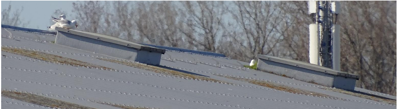
Figure 12 : Exemple d'éléments favorables à l'installation des nids de Goélands en toiture à pente
